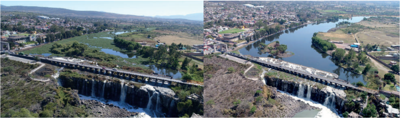
Limpeza de maleza acuática en la presa derivadora “El Salto”.
