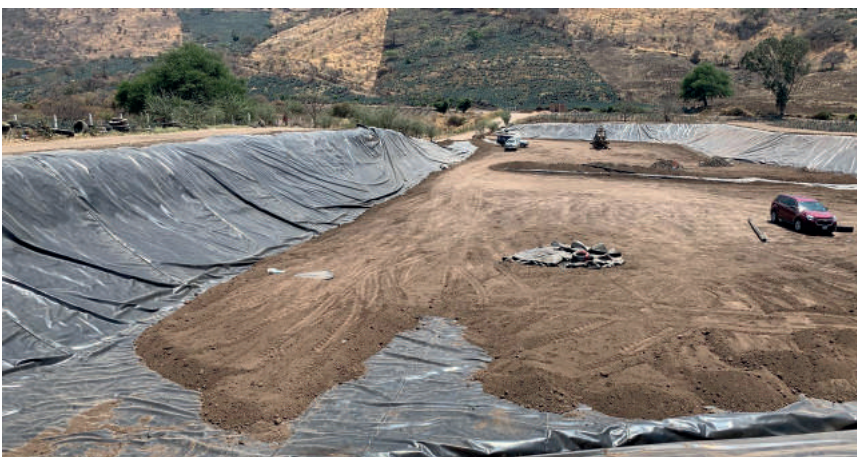
Avances en la ampliación del relleno sanitario Atotonilco.
